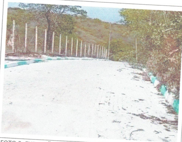
FOTO 2: EXECUÇÃO DE PAVIMENTAÇÃO EM INTERTRAVADOS
