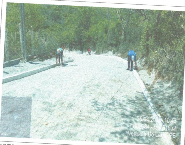
FOTO 3: EXECUÇÃO DE PAVIMENTAÇÃO EM INTERTRAVADOS
