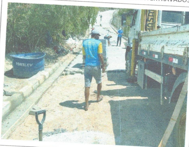
FOTO 4: EXECUÇÃO DE PAVIMENTAÇÃO EM INTERTRAVADOS
