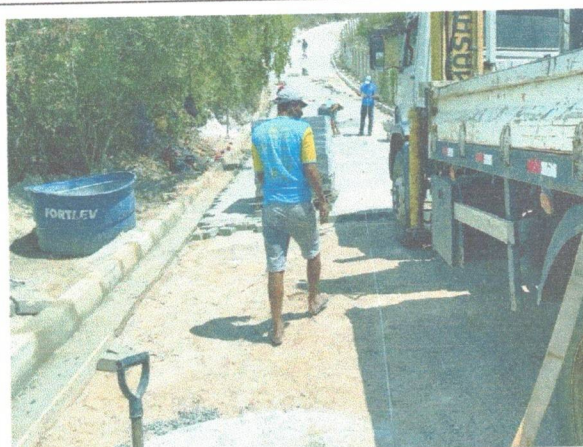
FOTO 4: EXECUÇÃO DE PAVIMENTAÇÃO EM INTERTRAVADOS
