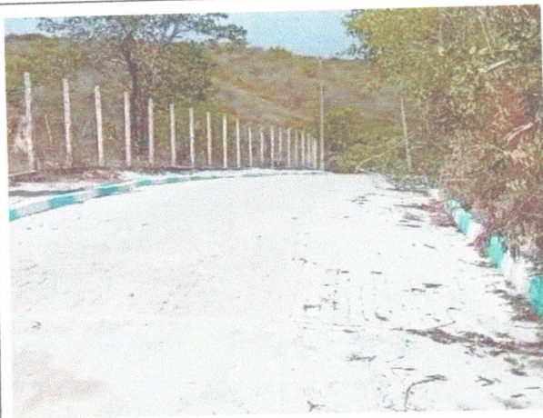
FOTO 2: EXECUÇÃO DE PAVIMENTAÇÃO EM INTERTRAVADOS
