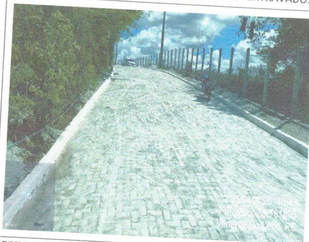
FOTO 6: EXECUÇÃO DE PAVIMENTAÇÃO EM INTERTRAVADOS
