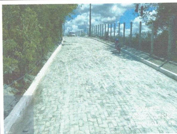
FOTO 6: EXECUÇÃO DE PAVIMENTAÇÃO EM INTERTRAVADOS
