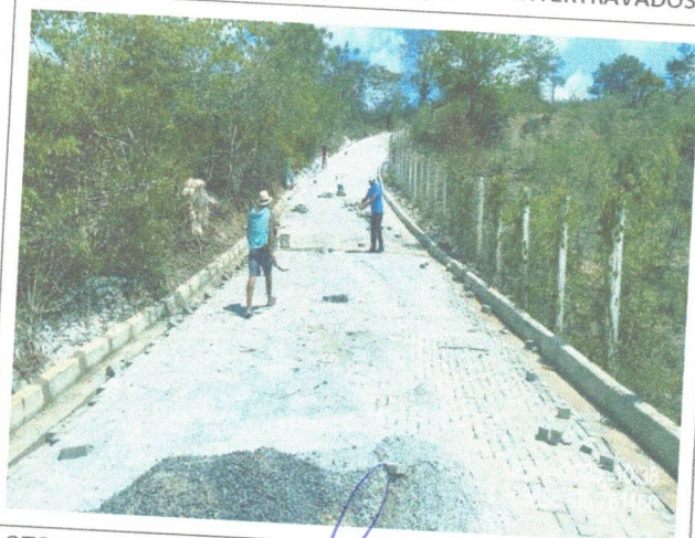
FOTO 5: EXECUÇÃO DE PAVIMENTAÇÃO EM INTERTRAVADOS
